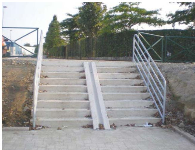
Goulotte au niveau d'une passerelle
